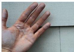
Рис. 3. Меління лакофарбового покриття
