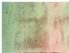
Рис. 3. Меління лакофарбового покриття
